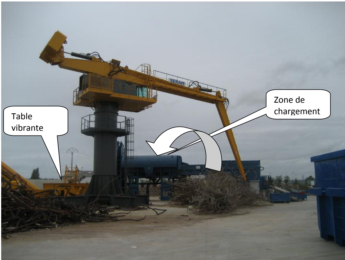
Photo de l'installation du site de Migné-Auxances (86440)
